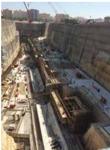
Doha Metro, Qatar
