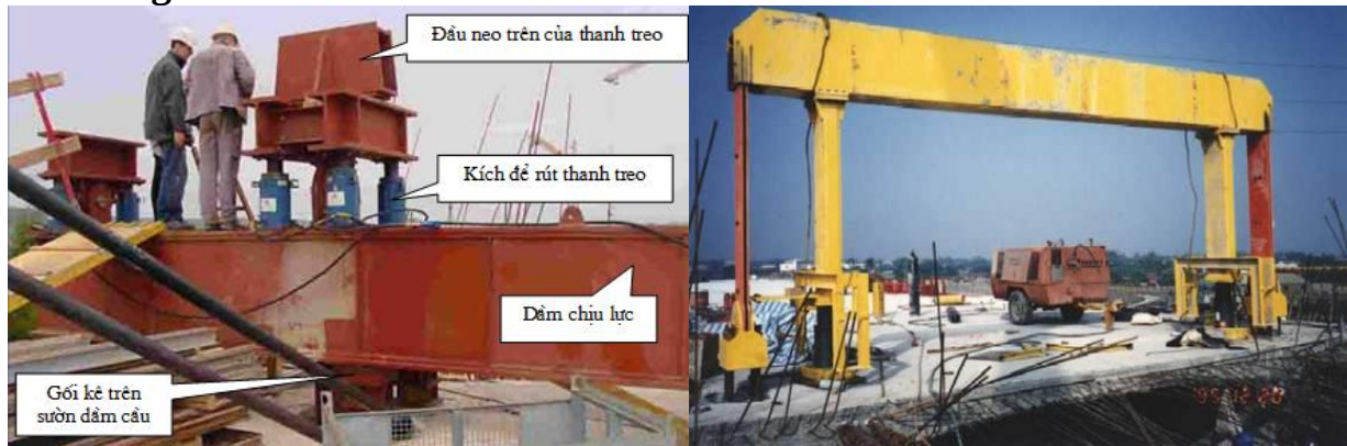
Khung treo hệ MSS chạy dưới
