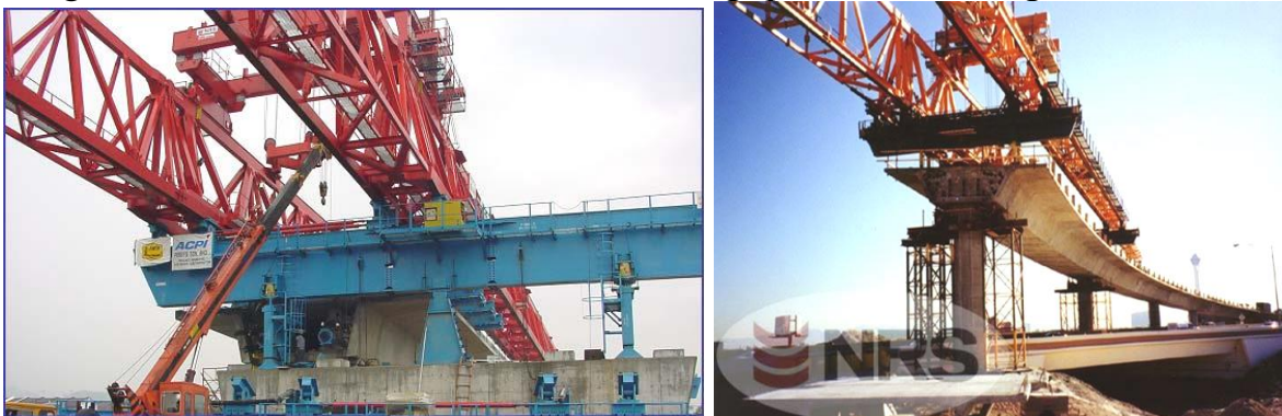
Đà giáo kiểu chạy trên kê lên đỉnh trụ và kê lên phân nhịp đã lắp
