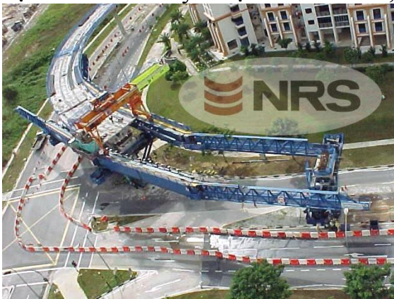
Dầm-dàn chính lắp hẫng kiểu chạy dưới
