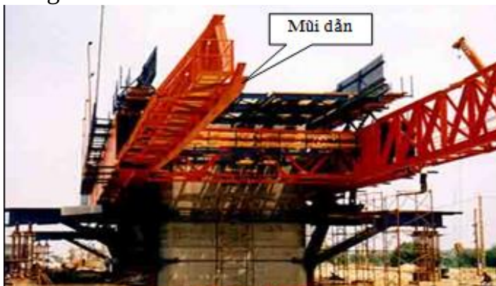
Hệ mũi dẫn cho loại chạy dưới
